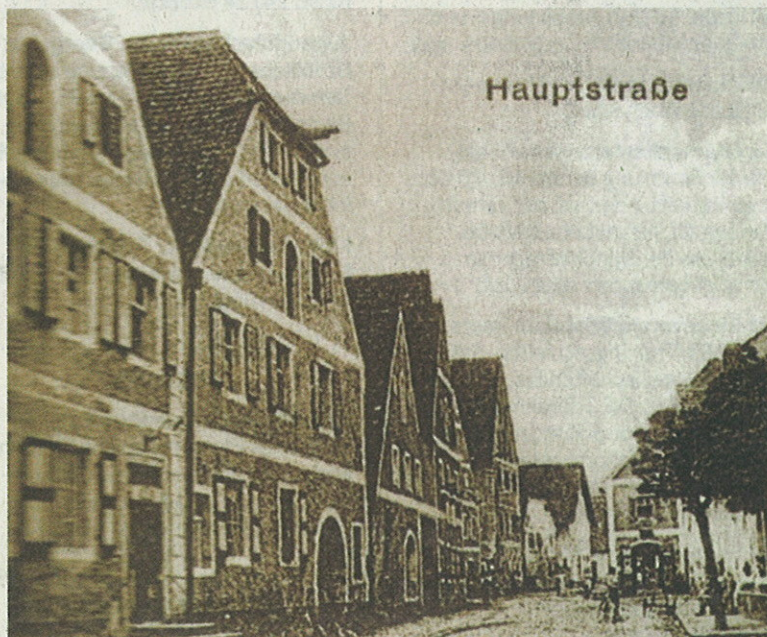
Die steinernen Mauern erinnern an die Hopfengärten im Lauterachtal (oben). Dachöffnungen prägten die Häuser Schmidmühlens: Hier wurde der Hopfen eingelagert (unten). Foto/Repro: ajp
